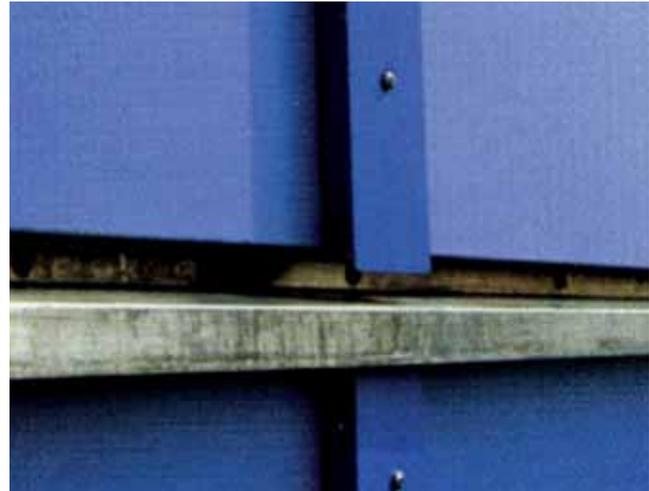
**Abbildung 5:** Zementgebundene Holzspanplatte, 8 bzw. 12 mm. Deckend farbig behandelt. Z-Profil für Schmalflächenschutz (aus [8])
